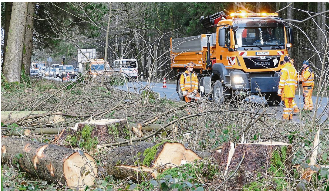
Aufräumarbeiten: Mitarbeiter der Straßenmeisterei des Staatlichen Bauamts Rosenheim entfernten gestern Totholz entlang der B 318, was im Berufsverkehr erhebliche Verkehrsbehinderungen zur Folge hatte. FOTO: ANDREAS LEDER
